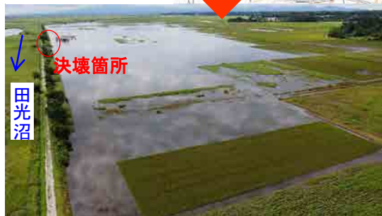
②浸水状況 8/14
