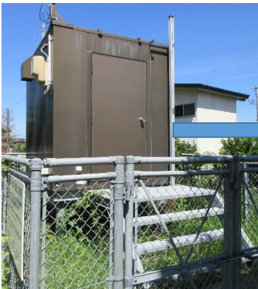
常時監視測定局の外観
