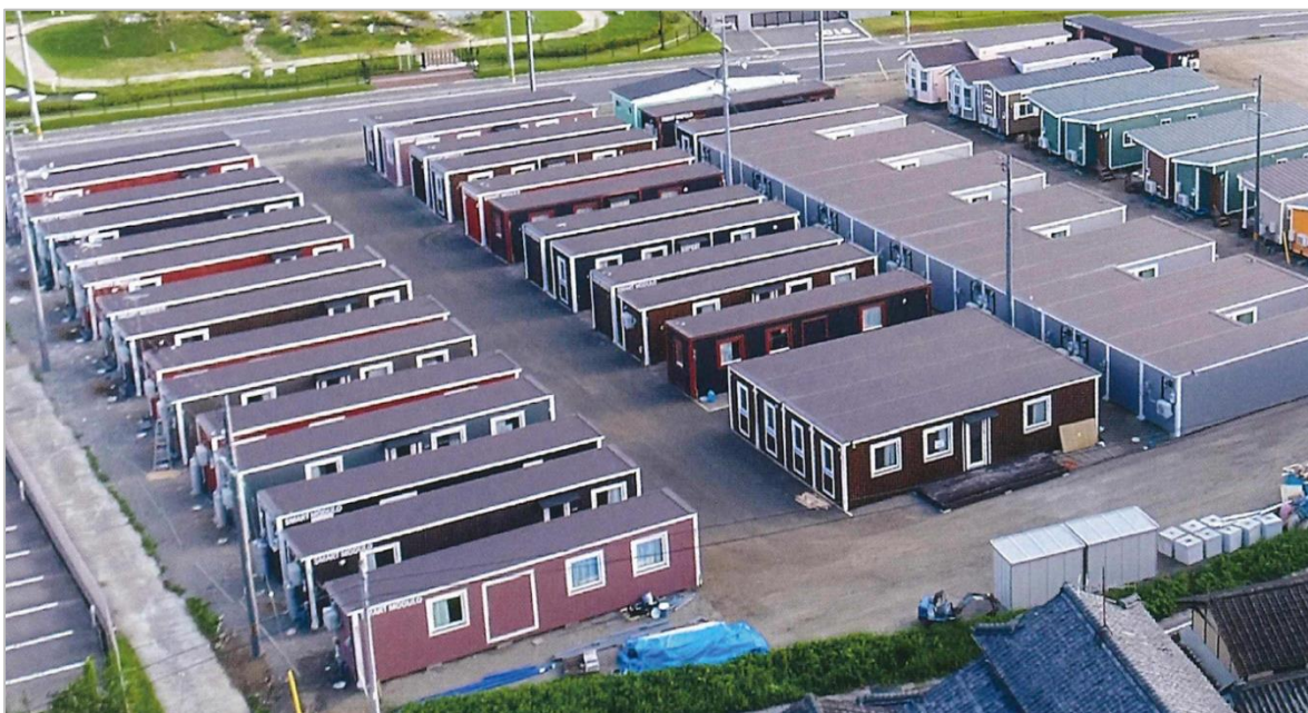
【岡山県倉敷市での活用事例（平成30年7月豪雨災害により設置された応急仮設住宅）】
