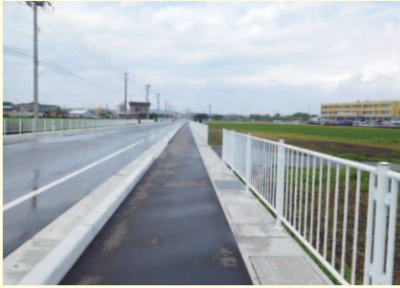
県立青森工業高等学校の移転に伴い拡幅された歩道
