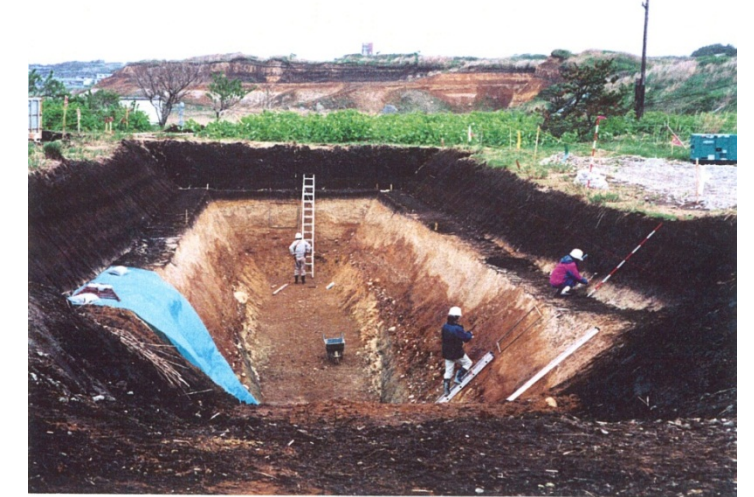
図5 トレンチ調査作業状況（事例）
