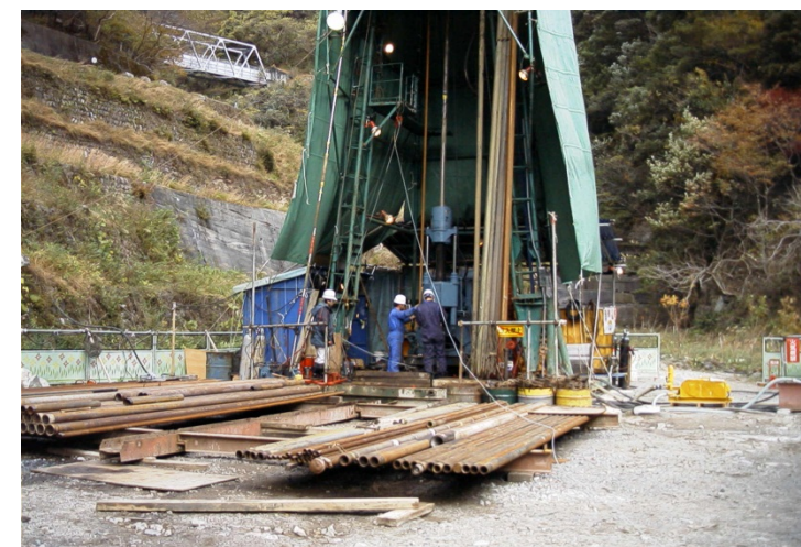
図4 大深度ボーリング作業状況（事例）
