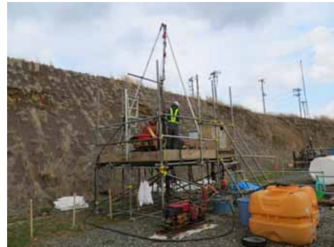
図2 ボーリング調査作業状況 (事例)
