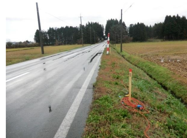
図5 受振器の設置状況(事例)
