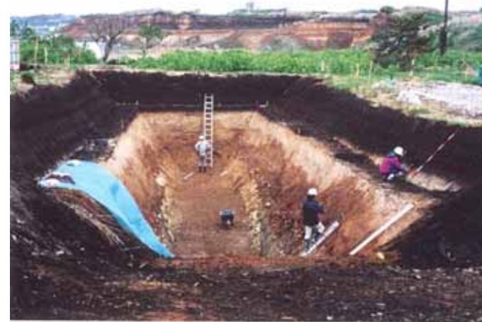
図4 トレンチ調査作業状況 (事例)
