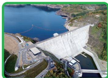
■津軽ダムと津軽発電所 (西目屋村)
