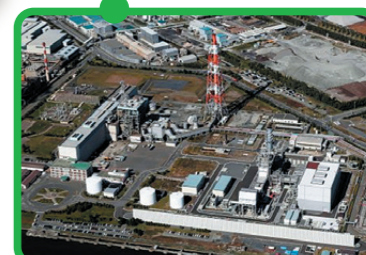
■八戸火力発電所(八戸市)
