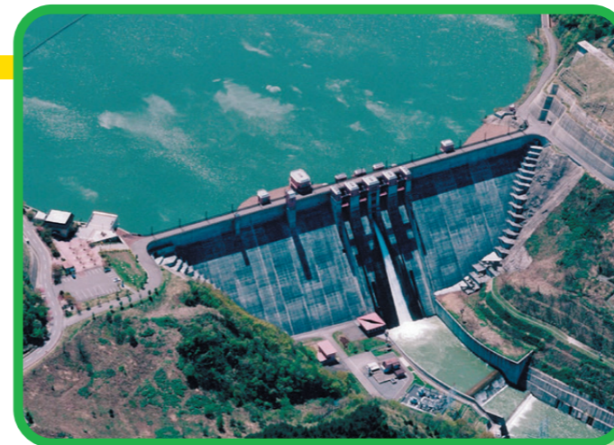
★浅瀬石川ダムと浅瀬石川発電所(黒石市、平川市)
