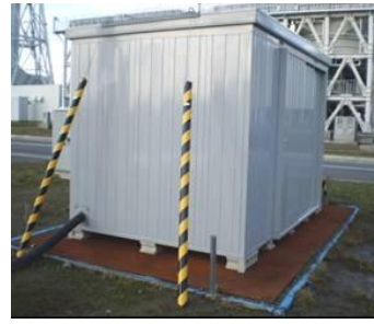
図2 電源ケーブル小屋の補強
