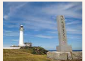
本州最北東端に立つ尻屋崎灯台
