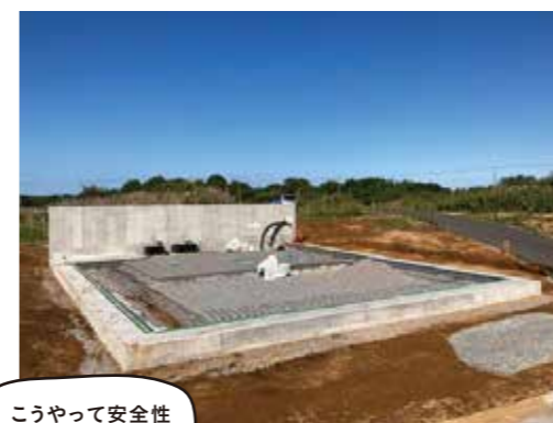
地下式軽油貯蔵タンクの工事現場
