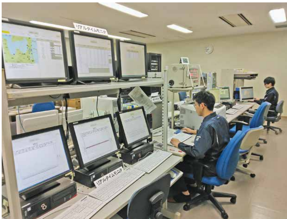
原子力センターテレメータ室
