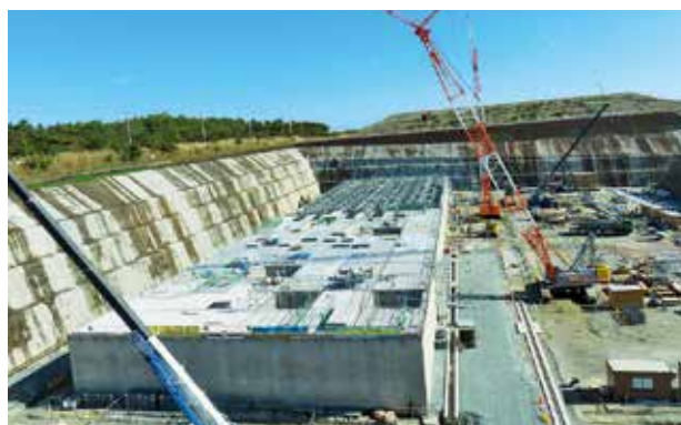
3号廃棄物埋設施設 (建設中写真)
