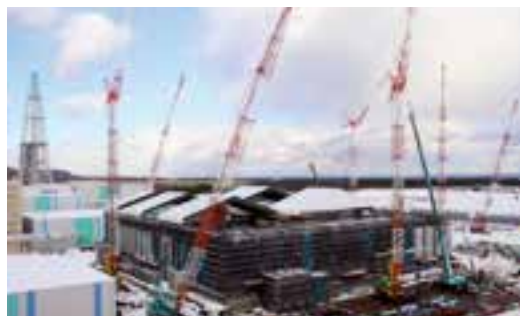
MOX燃料工場（建設中写真）
