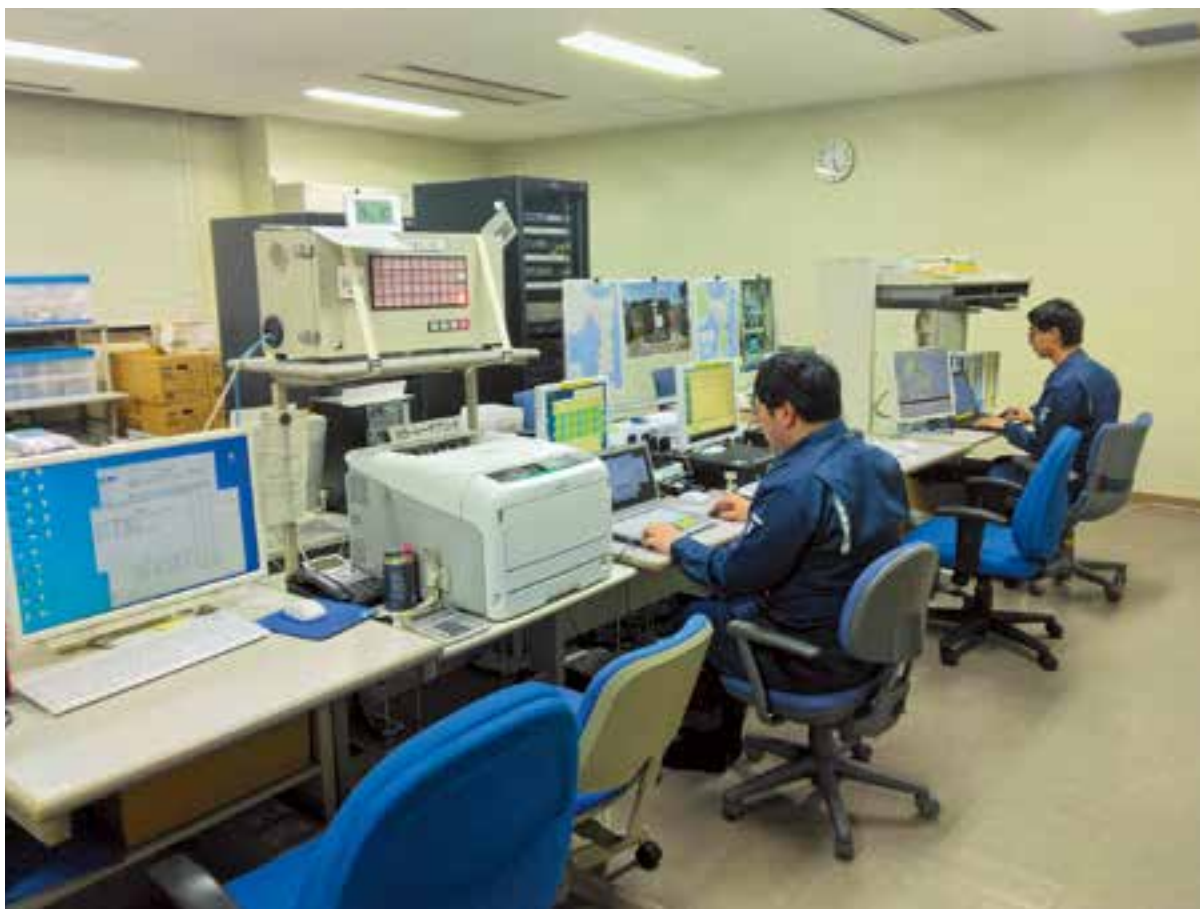
原子力センターテレメータ室
