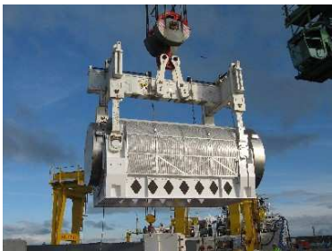
むつ小川原港での荷揚げ作業
