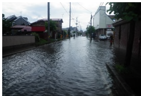
平成26年9月大雨による道路の冠水状況（五所川原市）
