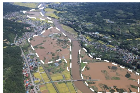
平成 25 年台風 18 号による馬淵川の氾濫の状況（点線部分）
