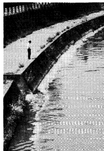
写真4 泡の発生状況(筒井橋付近)
