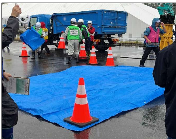
図8 仮置場の設置①
