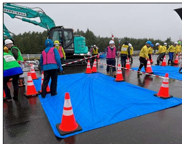
図9 仮置場の設置②
