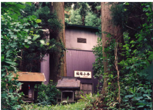
図4. 蝠蝠小舎正面
