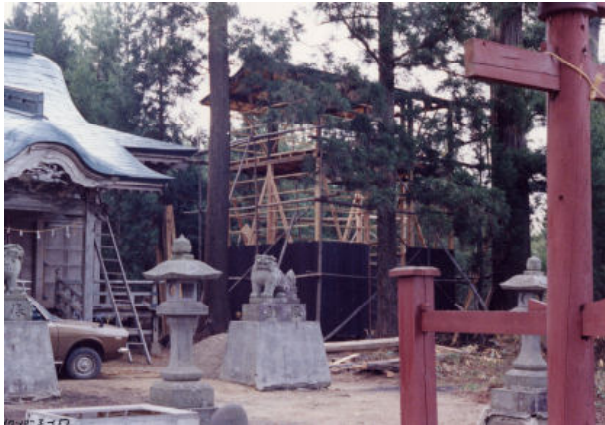
図3. 建設中の蝠蝠小舎（1977年）
