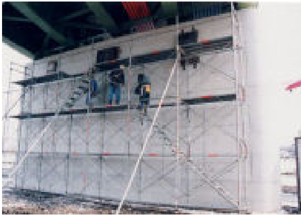
図 1 2．新尻内橋へのバットボックス取り付け（1999年）
