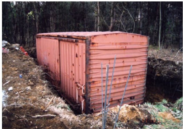
図17. 埋設中の人工洞穴用貨車(2004年)
