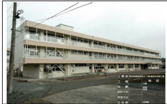
改修後の写真(担当所課保管)
