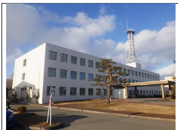
改修後の写真(担当所課保管)
