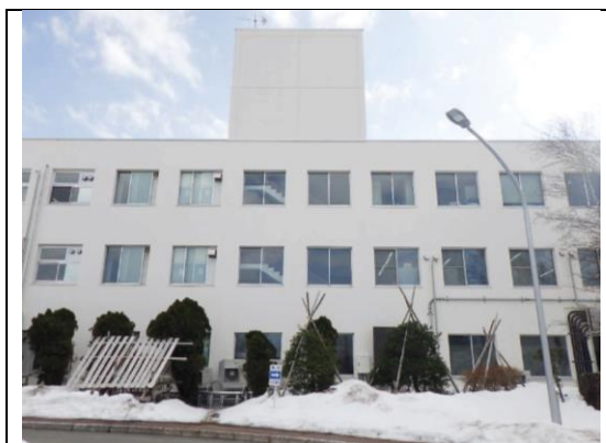
改修後の写真(担当所課保管)
