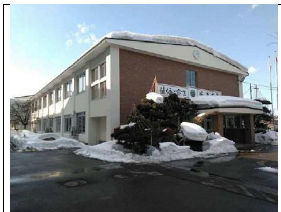
改修後の写真(担当所課保管)
