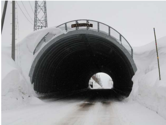
城ヶ倉スノーシェルター
