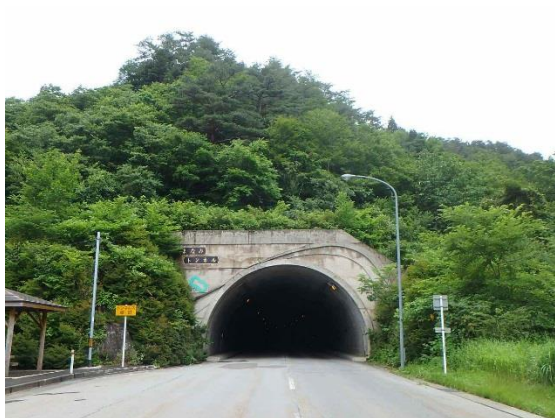
鱒ヶ沢蟹田線 やまなみトンネル
