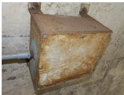
図-6 トンネル本体工及び附属物の損傷状況の一例
