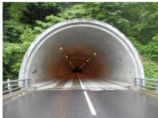
岩崎西目屋弘前線 寒沢トンネル
