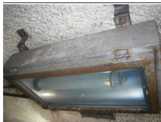
図-6 トンネル本体工及び附属物の損傷状況の一例
