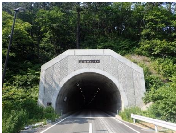
国道338号 泊・白糠トンネル
