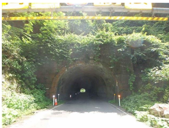
浅水南部線 手倉橋隧道
