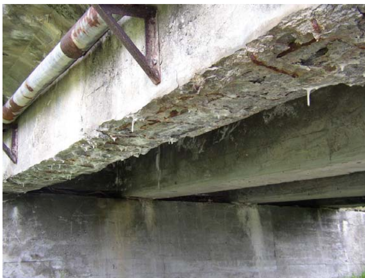
図 3-9 太平洋側の凍害を受けた橋梁
