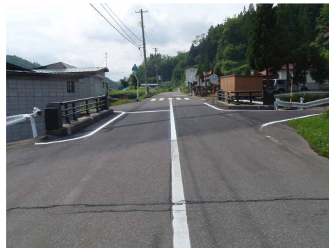
国道454号 小国第2号橋【補修後】
