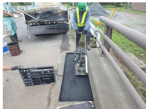
上北地域整備部緊急措置（橋面補修）
