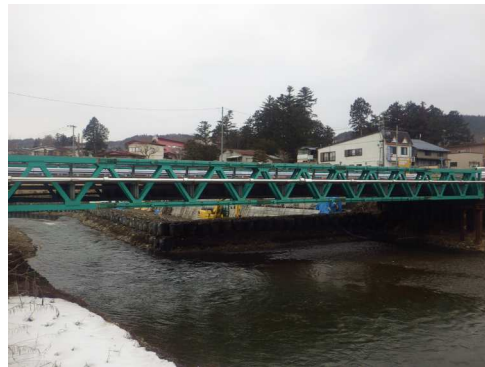
三戸南部線 黄金橋【施工中】
