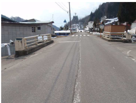
国道454号 小国第2号橋【補修前】
