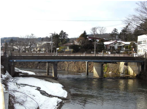
三戸南部線 黄金橋【施工前】
