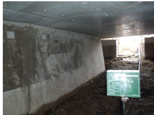
八戸野辺地線 坂下橋【補修後】
