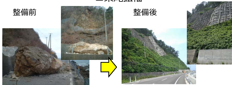
▲白砂法面対策(災害復旧、災害防除)
