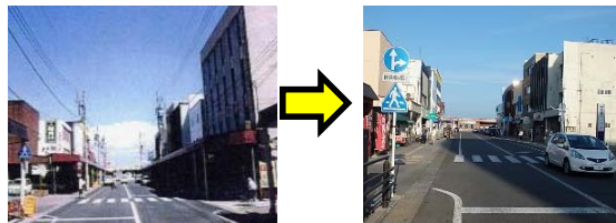
▲ アーケード撤去・電線地中化
