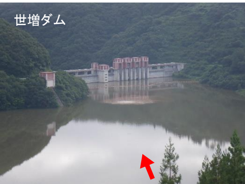
ダムへ貯留状況 8/4 6:00頃 貯水位EL98.65m
