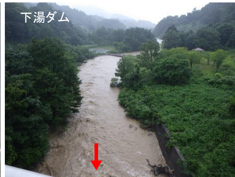
ダムへの流入状況 8/9 16:00頃 流入量約110m 3 /s
