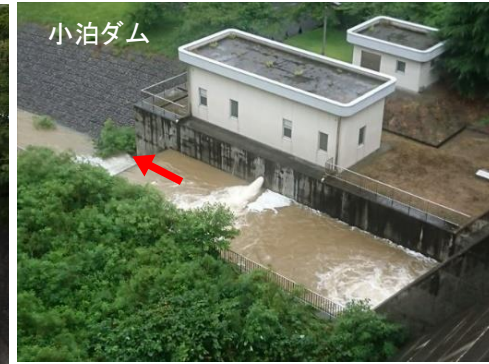
貯水位低下のためバルブから放流 8/15 16:00頃
