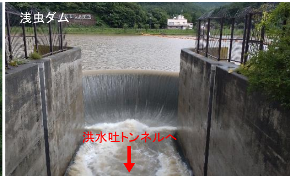
洪水吐きトンネルへの放流状況 8/12 5:30頃 放流量約4.4m 3 /s
