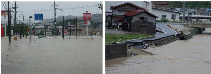
氾濫する中村川 護岸の被災状況
