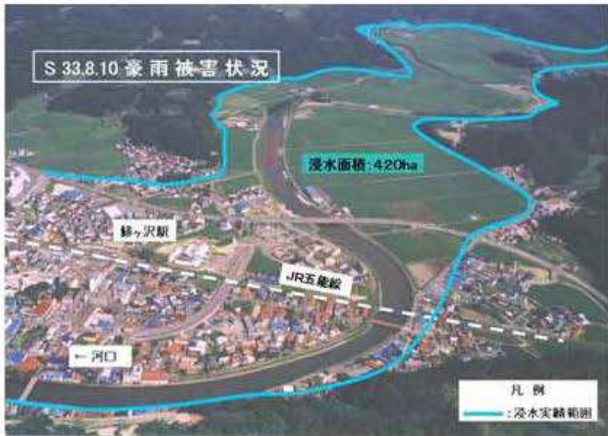
図1-7 S33.8.10 洪水被害状況
