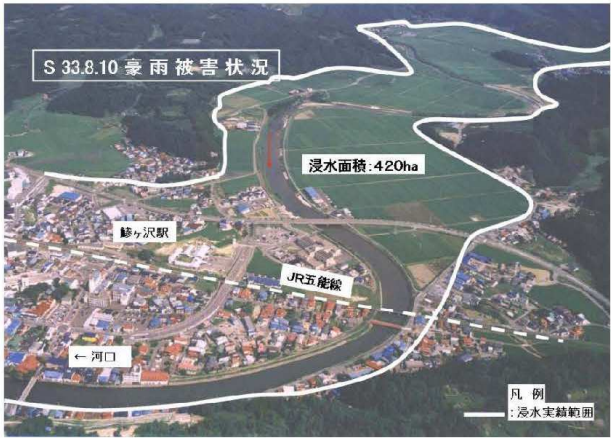
図 1-7 S33.8.10 洪水被害状況
