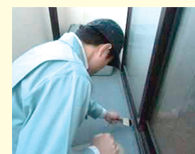
「外部(バルコニー)」調査の様子
