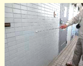
「外部(外壁)」調査の様子
