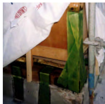
アラミド繊維による施工
