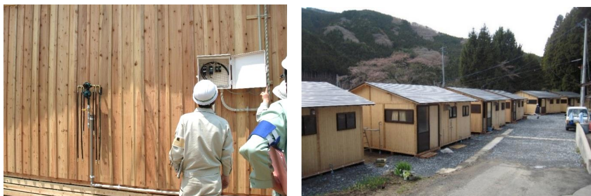
（完了検査状況）
