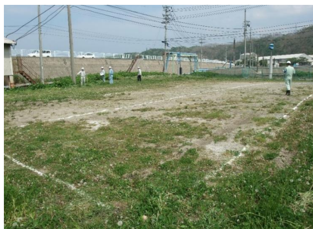
(縄張り検査状況)
