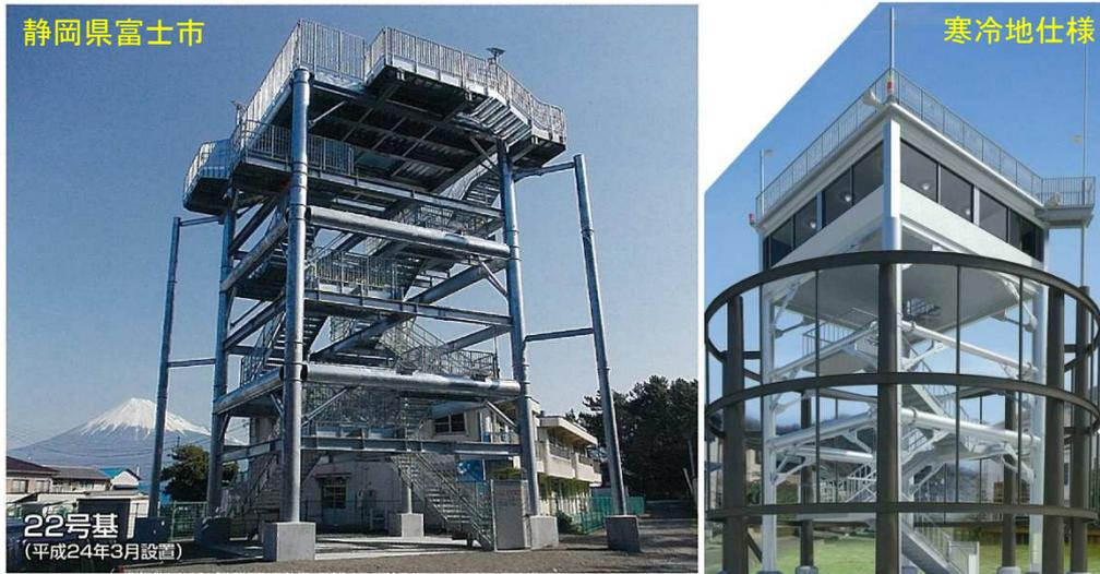
図-8.1 津波緊急避難施設の整備例
