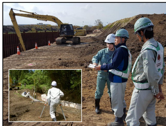
【施工検査の状況（出先機関）】
