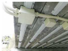
写真-6 線状流電陽極実施例
