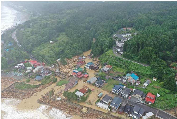
被災直後の小赤川付近（令和3年8月11日）
