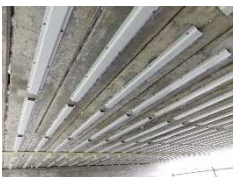
写真-5 線状流電陽極実施例
