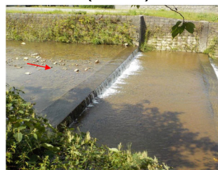
既設施設(落差工)写真
