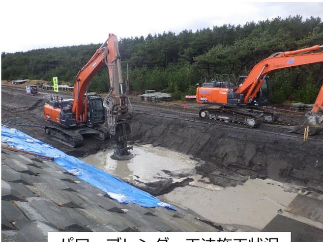
パワーブレンダー工法施工状況
