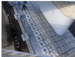
橋脚巻立て工 鉄筋組立て
