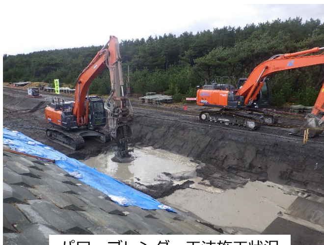
パワーブレンダー工法施工状況
