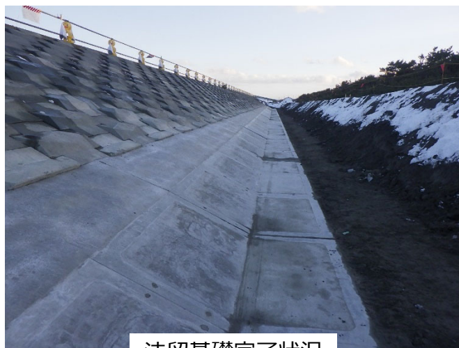
法留基礎完了状況
