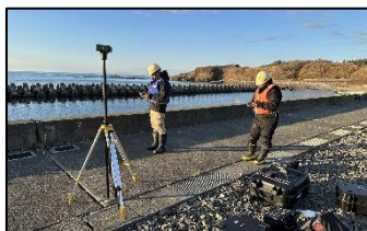
三次元点群測量状況（UAV）
