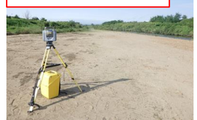
TLSによる出来形計測
