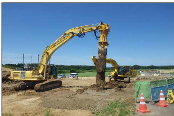
【 ICT中層混合施工状況 】
