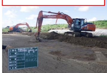
ICT建設機械による掘削
