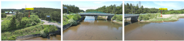
現場周辺写真
