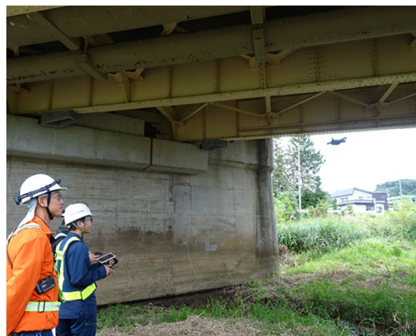
写真 小型ドローンを使用しての橋梁点検状況
