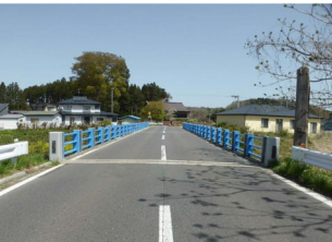
轟木橋 正面全景
