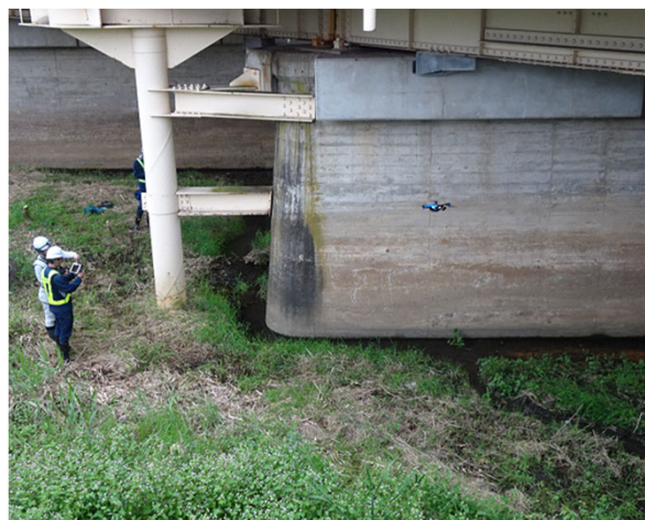
写真 小型ドローンを使用しての橋梁点検状況
