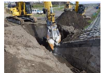
既設堤防取壊し状況
