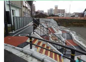
完成【Bブロック】起点側
