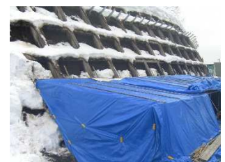
法面除雪・養生小屋設置
