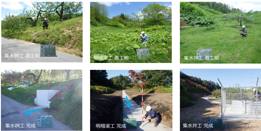
着工前・完成
