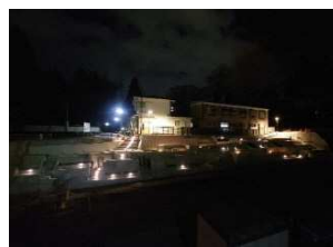
完成 夜間【Bブロック】全景
