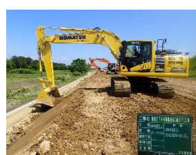
【GNSSによる盛土締固め】
