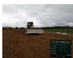
【GNSSによる盛土締固め】
