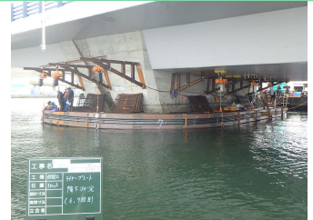
電動ウインチによるライナー降下作業
