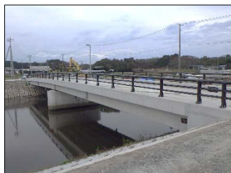
PC橋工完了時
