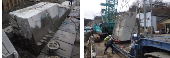
ワイヤーソーによる切断・撤去
