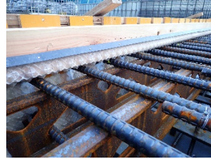
【鉛直打継処理シートの使用】
