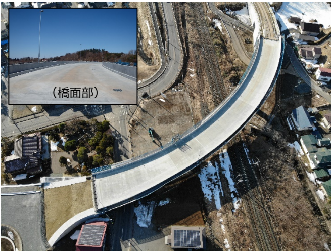
【完成状況写真】
