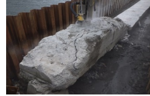
割岩機による取壊し
