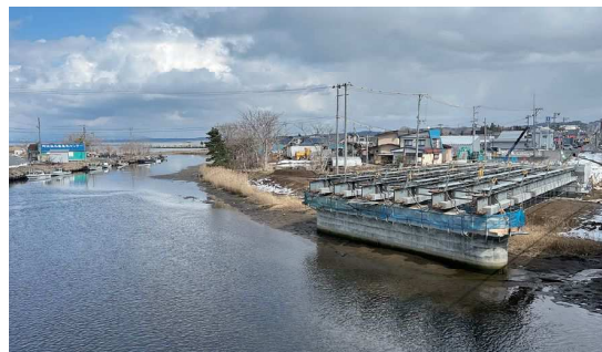
馬門野辺地線（野辺地橋）工事（野辺地町）
