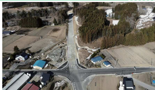
国道394号（榎林バイパス）工事（七戸町）
