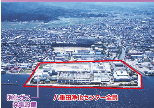
八重田浄化センター全景
