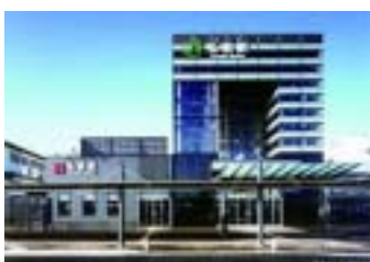
弘前駅自由通路外観
