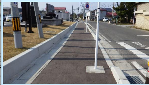
■基幹事業（道路） 市道伊勢道1号線
