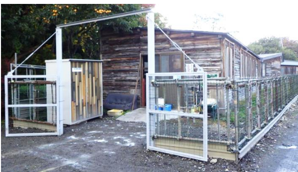
図8 C農場防護柵及び入口倉庫
