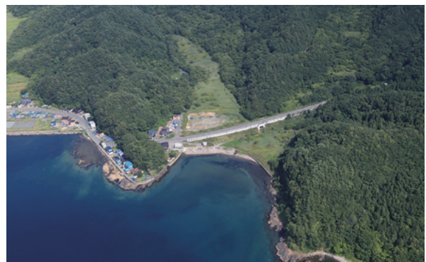
馬屋尻海岸 海岸堤防老朽化対策緊急事業
