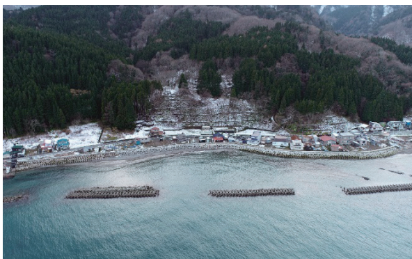
石崎海岸 海岸堤防老朽化対策緊急事業
