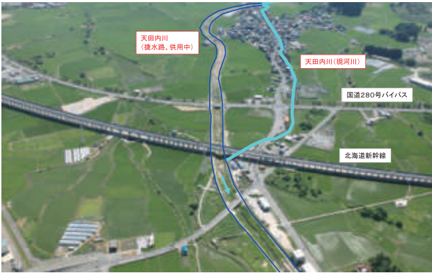
天田内川総合流域防災事業
