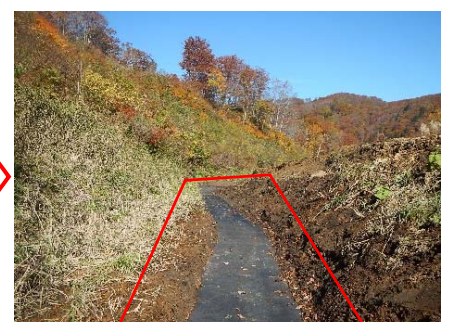
【完成】 吸出防止材を巻いて完成
