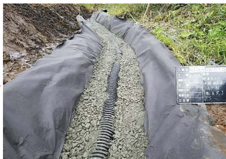
【施工中】 吸出防止材を敷き、ポリエチレン管の周りを 砕石で埋戻し
