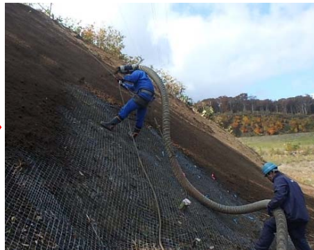
【施工中】 チップ材の吹付状況
