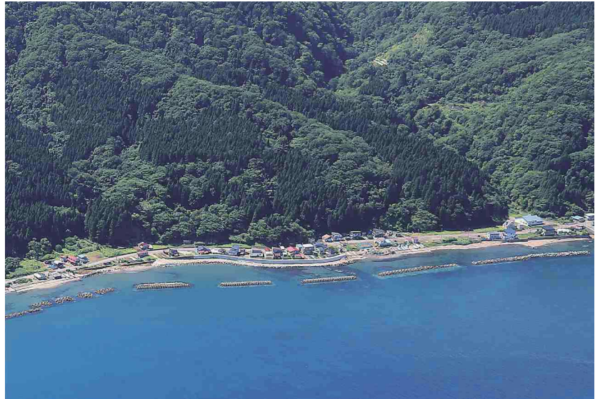
石崎海岸 海岸堤防老朽化対策緊急事業
