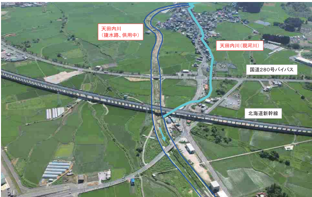
天田内川総合流域防災事業
